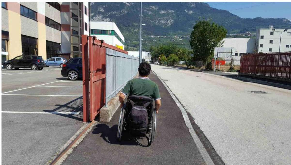
Raccordo accesso carralo errato pendenza trasversale >1.00%
