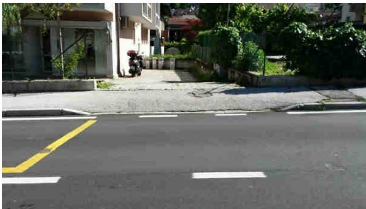
Raccordo accesso carralo errato pendenza trasversale >1.00% ( 11% - 25.7%)
